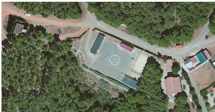
Helipuerto de la BRIF
