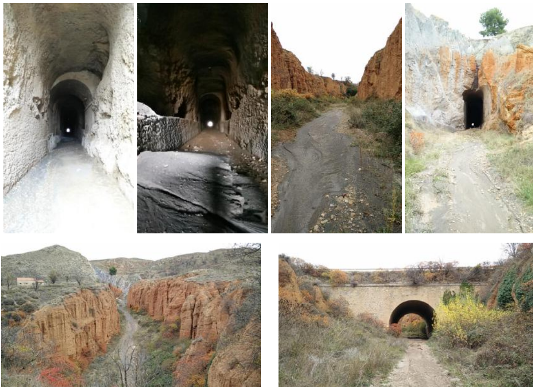
Imágenes del exterior e interior del Barranco de La Mina y túnel
