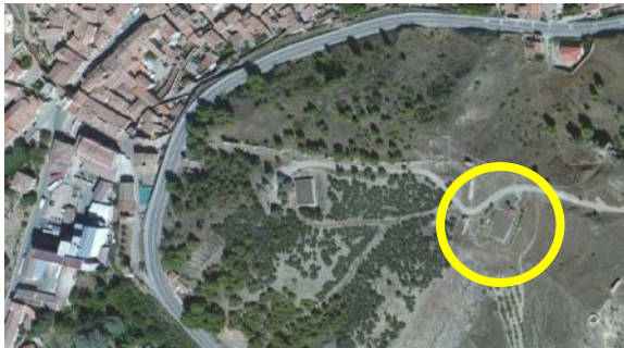
Depósito nuevo de San Jorge
