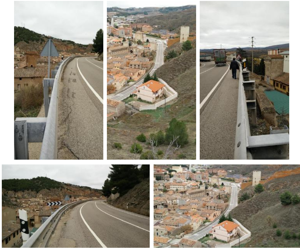
Vistas de la travesía de la N-234 sobre el casco urbano de Daroca
