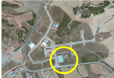
Sub-estación transformadora eléctrica
